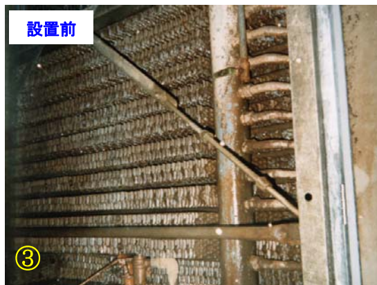
エコビームXL設置前の充填材等へのスケール付着状況
