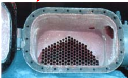
写真②: 吸収器の内部
